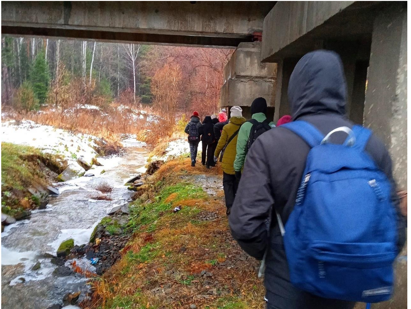
Фото 1. Прохождение под 2-м ж.д. мостом вдоль правого берега безымянного ручья.
